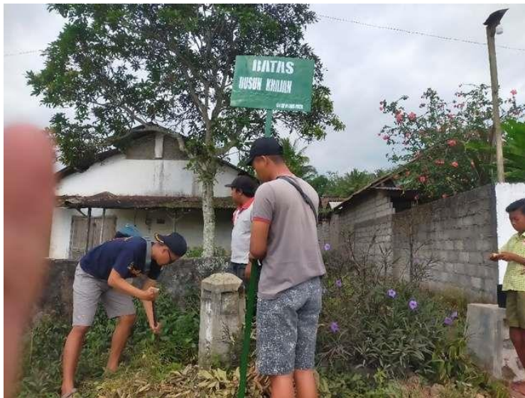
Gambar 5 : Pemasangan Batas Dusun Krjan
